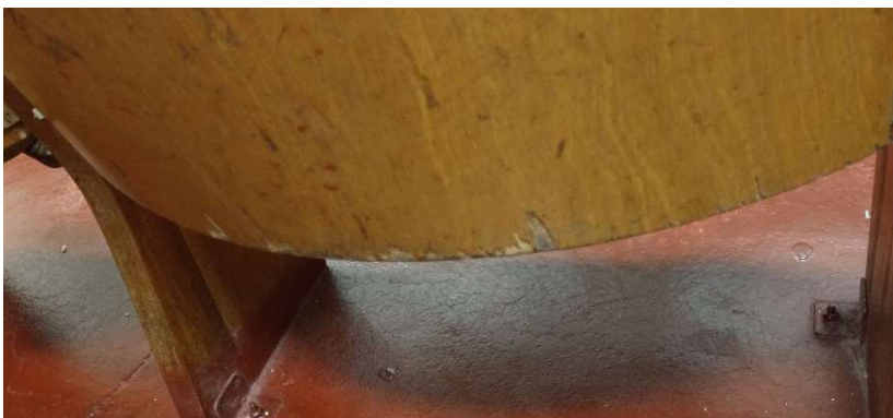
Ejemplo de daños a reparar con masilla a tono por la empresa contratista.
