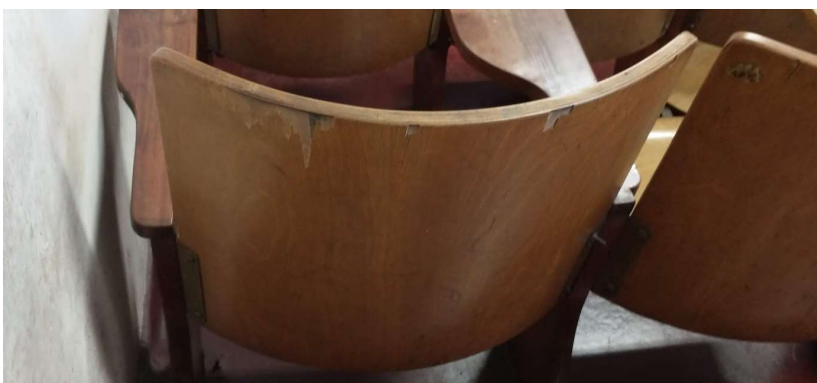
Otro ejemplo de posibles daños a reparar con masilla a tono por la empresa contratista.
