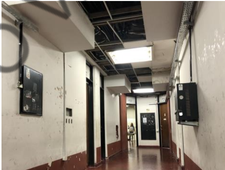
Cielorraso a desmontar en pasillo docentes.
