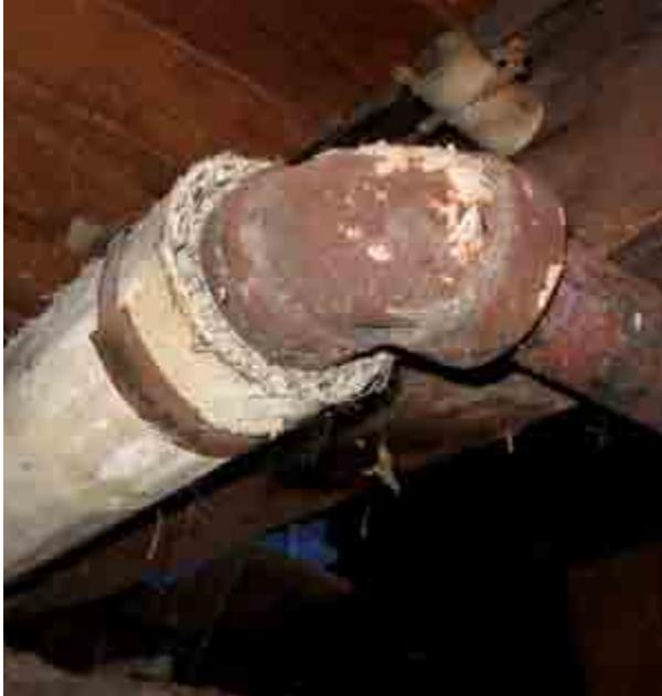
*Deterioro de tuberías recubiertas con asbesto en antiguas construcciones.*
