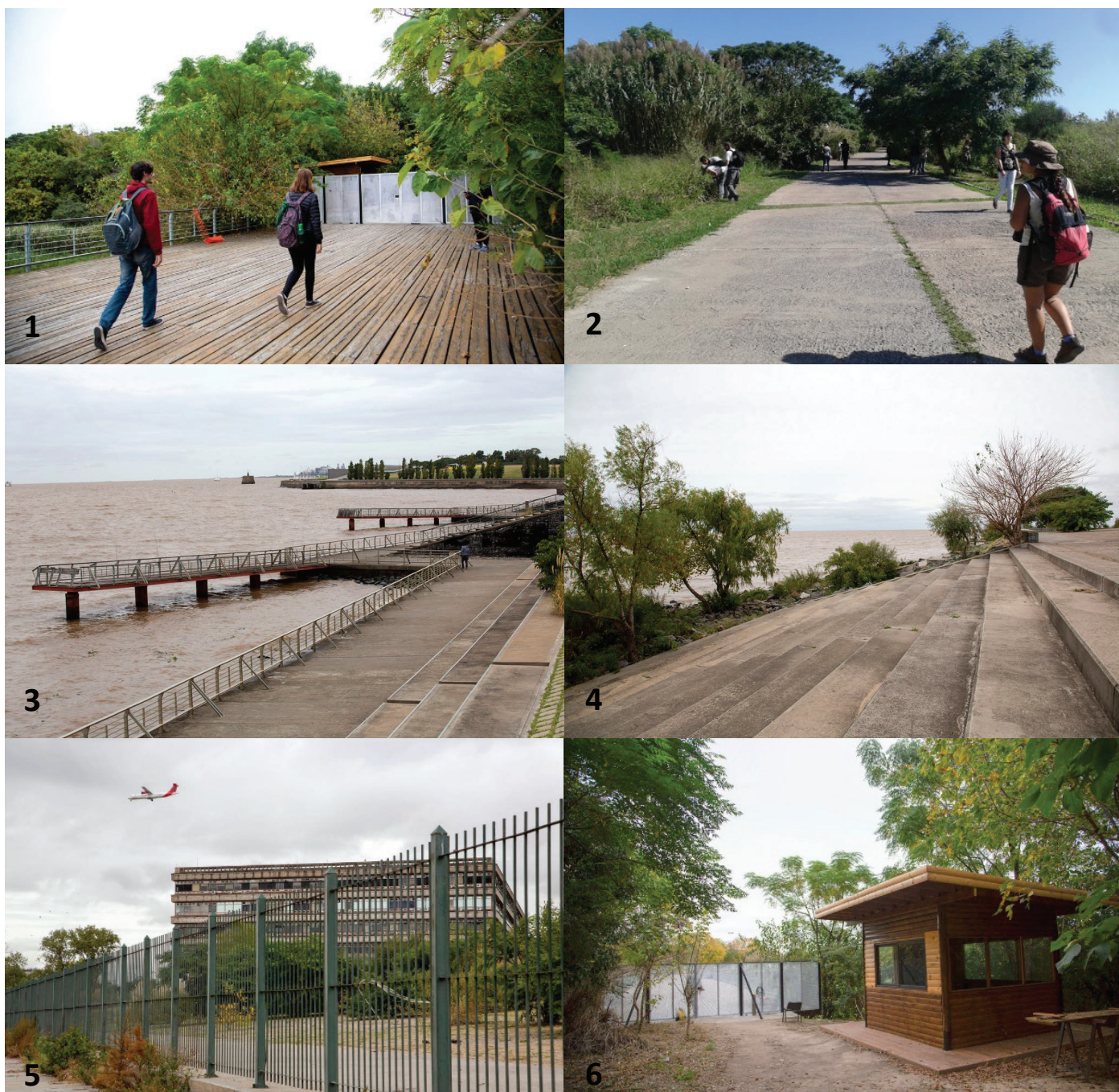
Figura 16: Infraestructura existente en el área. Por orden numérico: puente, camino, gaviones, escaleras, reja y cabina de seguridad en la entrada del puente. Fotos Victoria Gesualdi.
