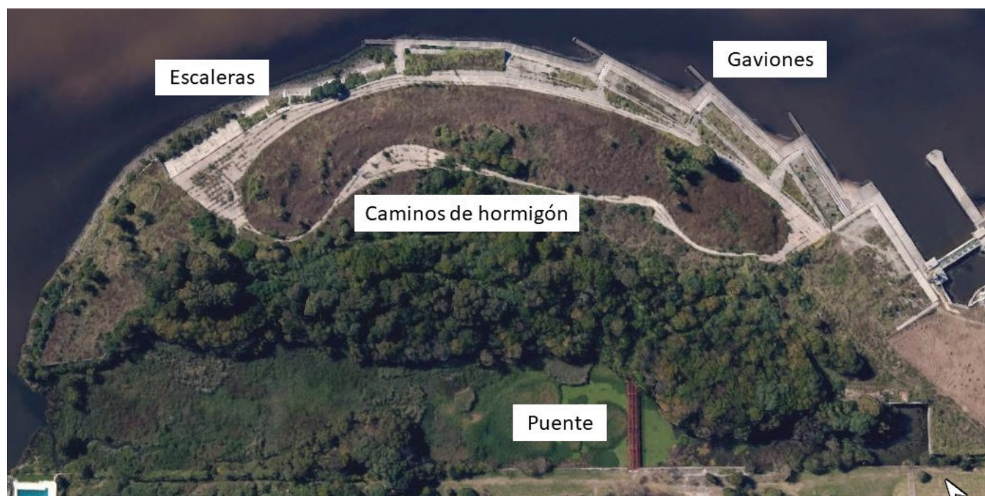
Figura 17. Infraestructura instalada en la reserva ecológica universitaria. Los recuadros blancos señalan los componentes más importantes. Algunas de estas estructuras se encuentran deterioradas o fueron construidas de manera incompleta.
