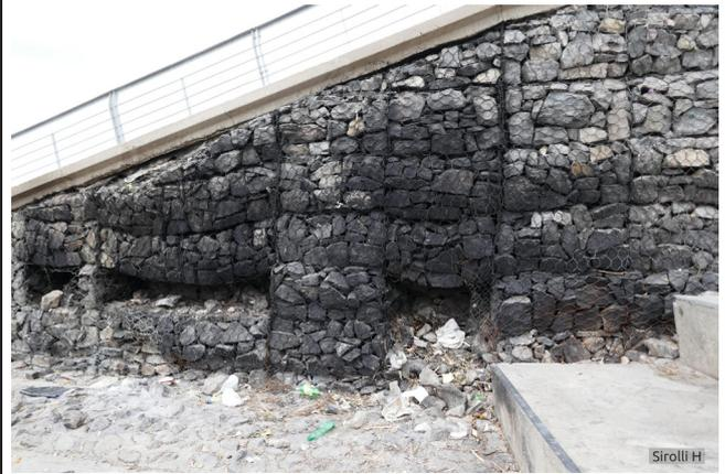
21. Gaviones. Hundimiento provocado por extracción de rocas de gaviones.
