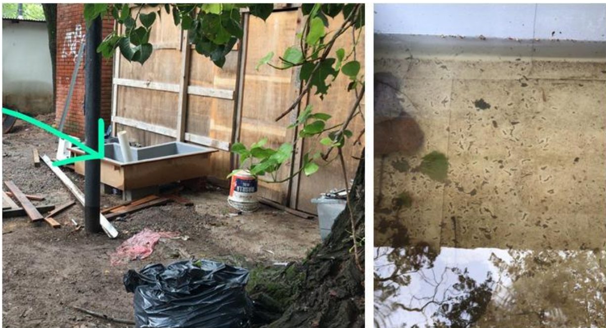
Figura 3. Pileta plástica en obra de edificio Cero+Infinito.
